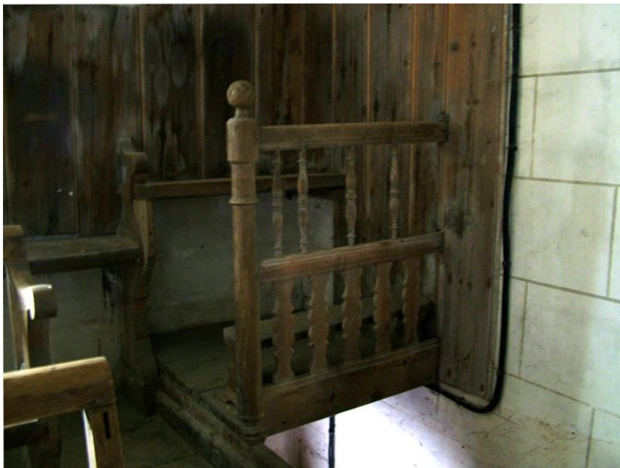
Petite tribune surplombant l'escalier.
