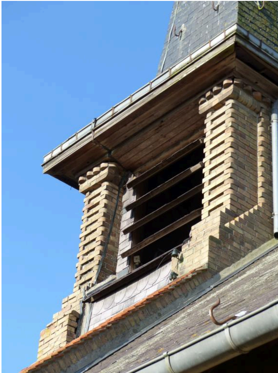
Vue de détail sur l'abat-son du clocher.
