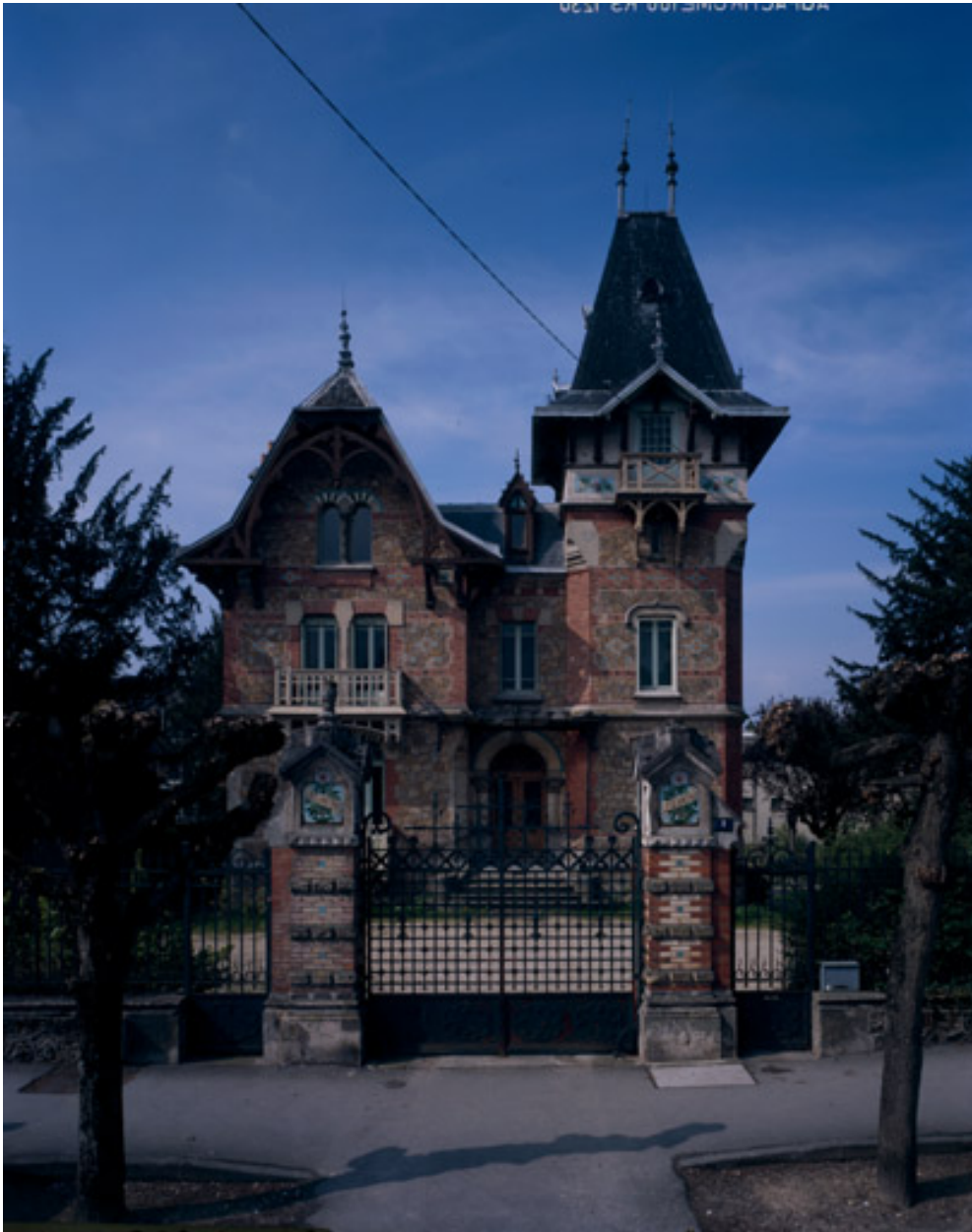
Vue rapprochée de la façade principale.
