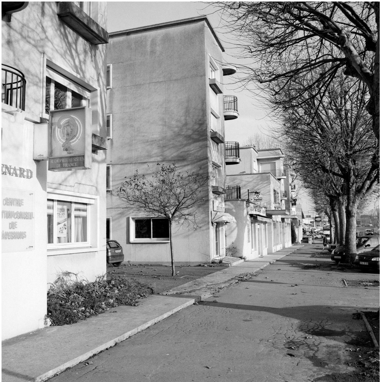
Vue générale rapprochée de l'alignement des deux immeubles en forme de H.
