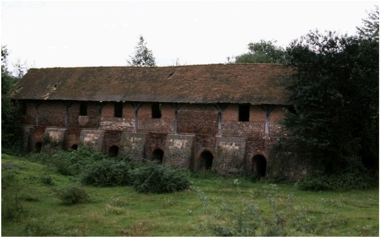
Four industriel de type Hoffmann, côté nord.
