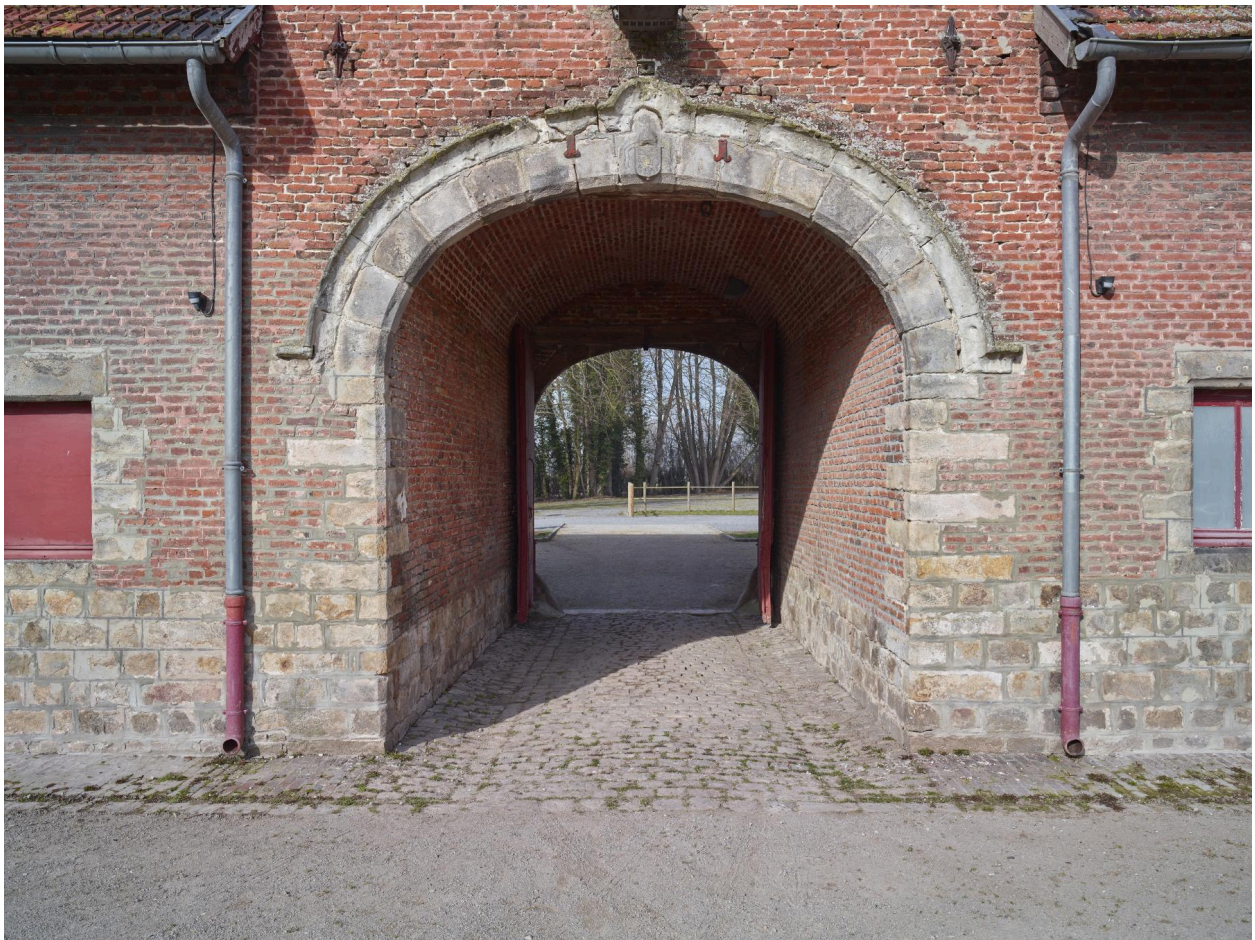
Passage charretier sous la tour porche. Vue prise depuis la cour intérieure. Blason de Jean Sarrazin en clé de voûte.
