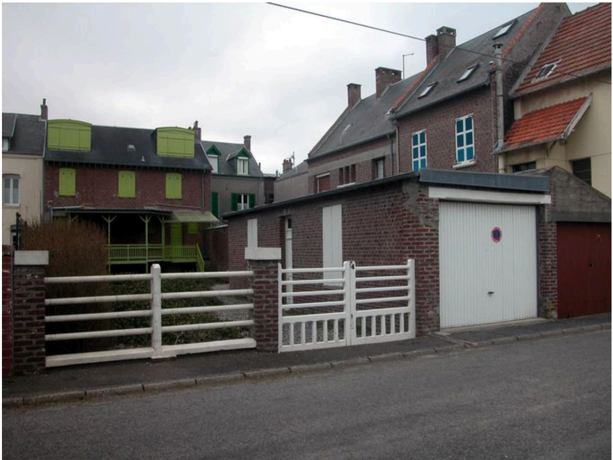
Vue d'ensemble, façade postérieure et garage isolé.
