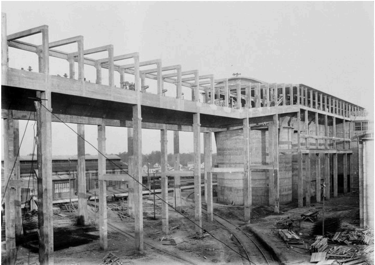
Construction de l'atelier de fabrication principal, vers 1925 (AP).
