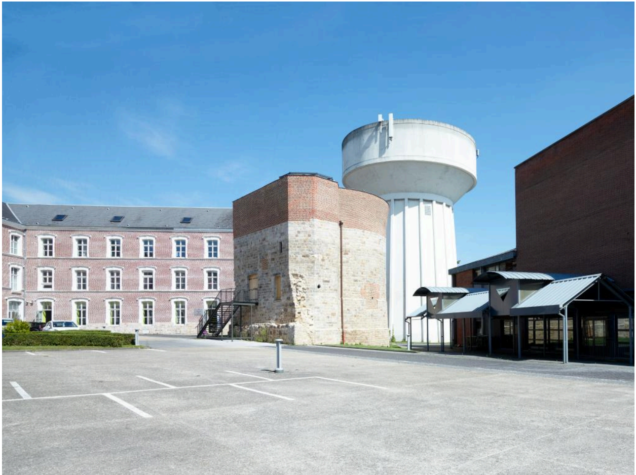
Vue générale du nord-ouest de la tour, prise depuis la cour du lycée.
