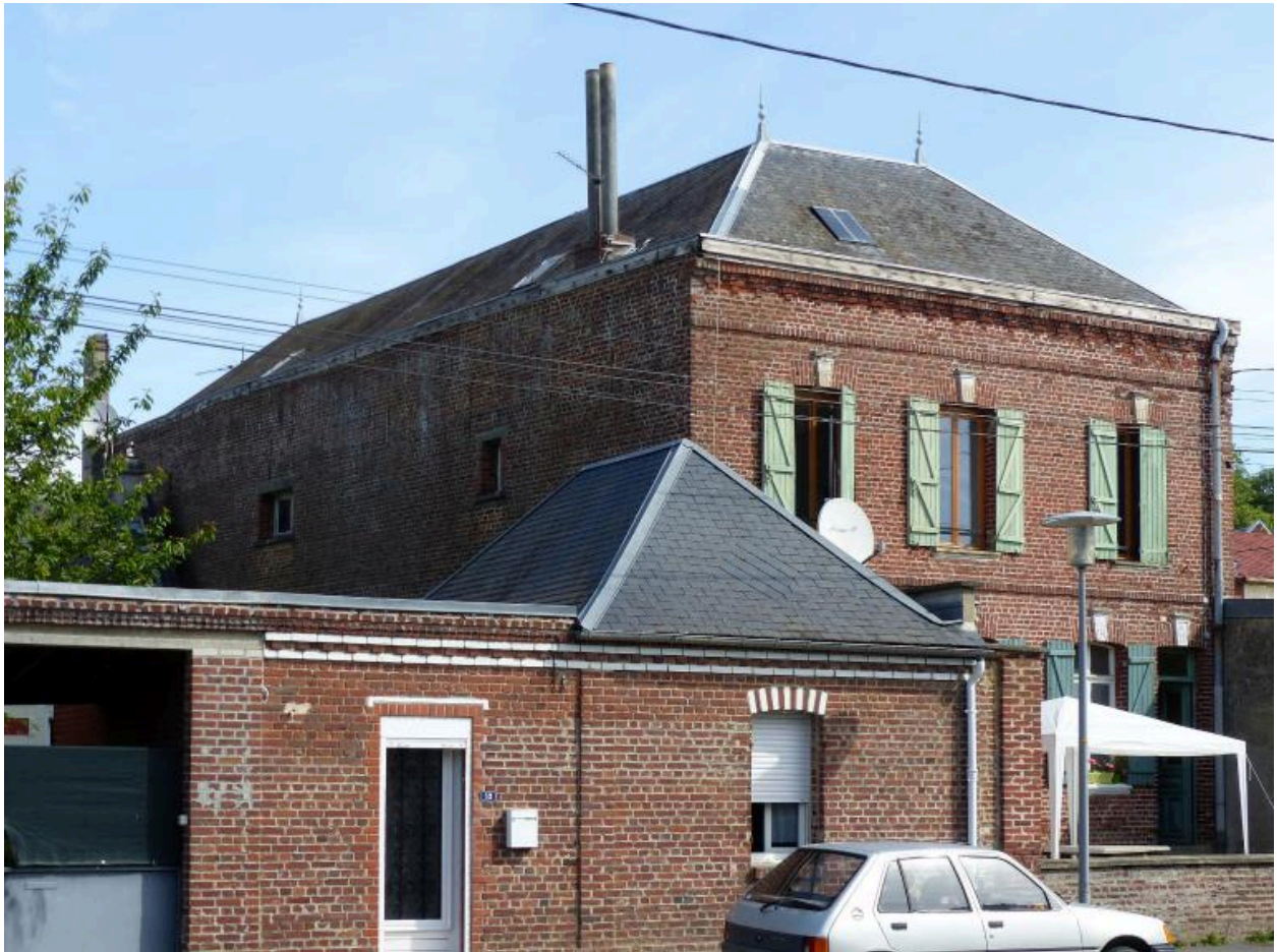
Vue de détail sur les anciens ateliers.
