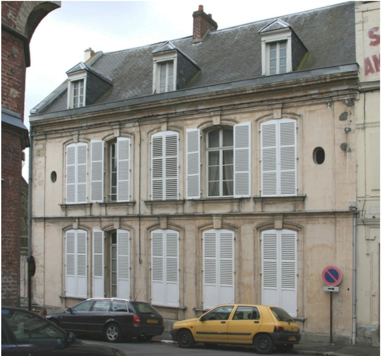
Façade antérieure du logement patronal.
