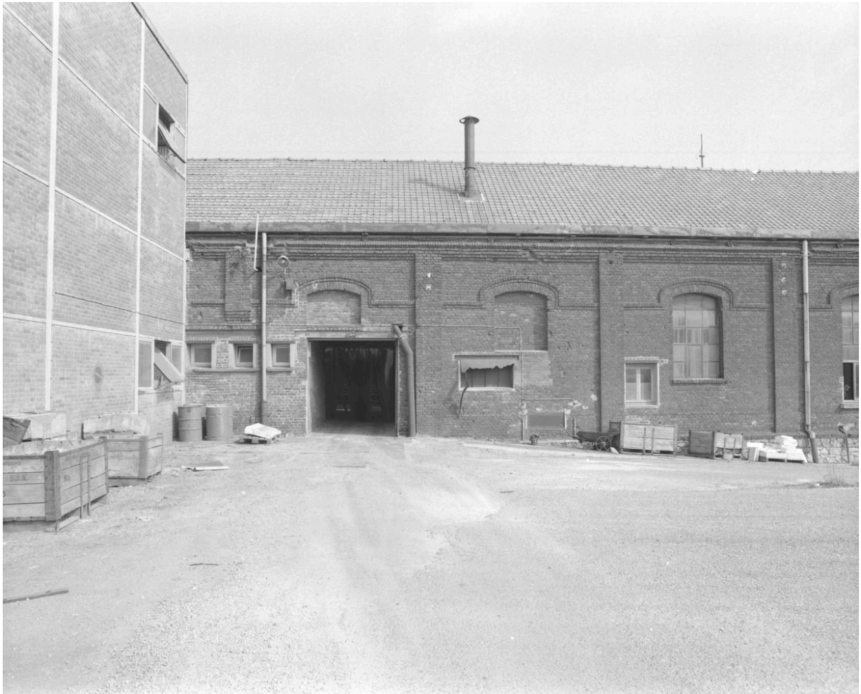
Sortie de la halle à pots.
