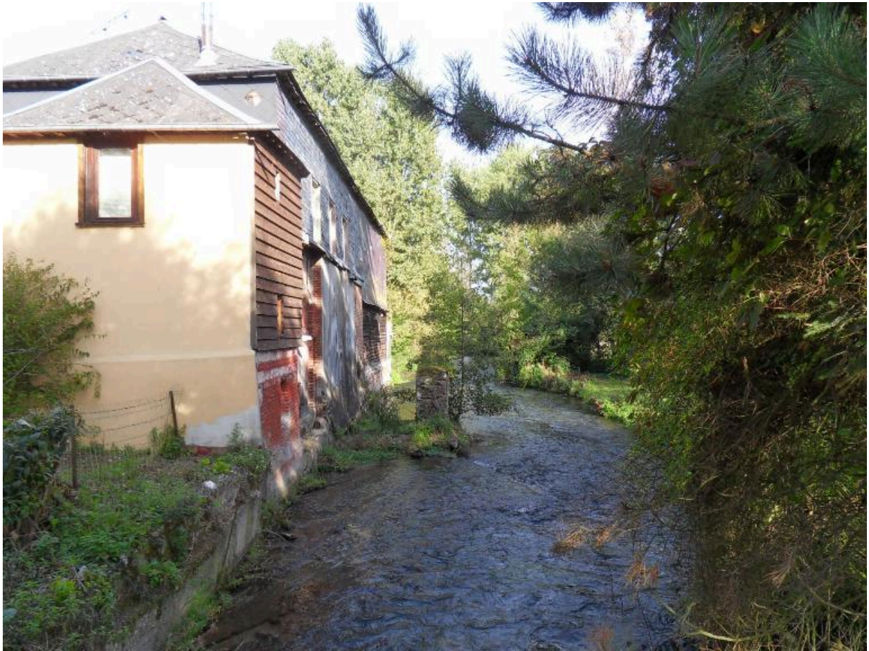
L'ancien moulin d'Uzenneville, vu depuis le pont.
