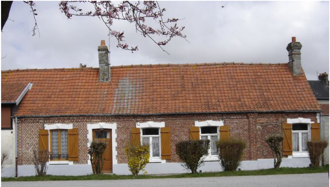
Vue de face du logis.
