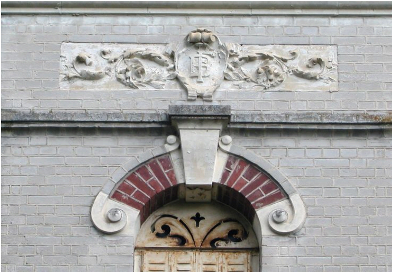
Détail des initiales BF sculptées sur un dessus de fenêtre du logement patronal.
