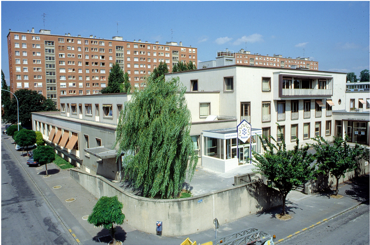
Vue de l'élévation du bâtiment de la Sécurité Sociale donnant sur la place de Wattignies.
