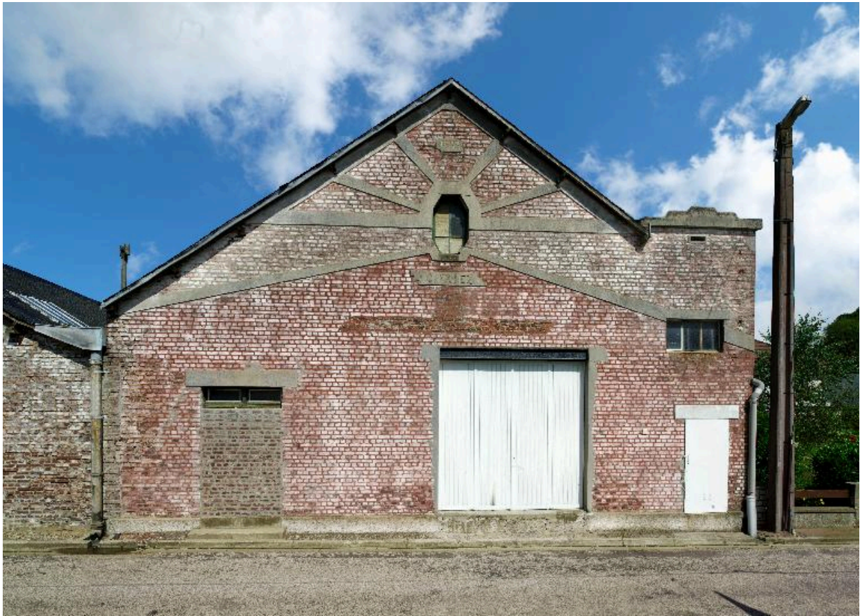
Ancienne usine Priez, vue de la façade de l'ancien hangar depuis la rue du 1er mai.
