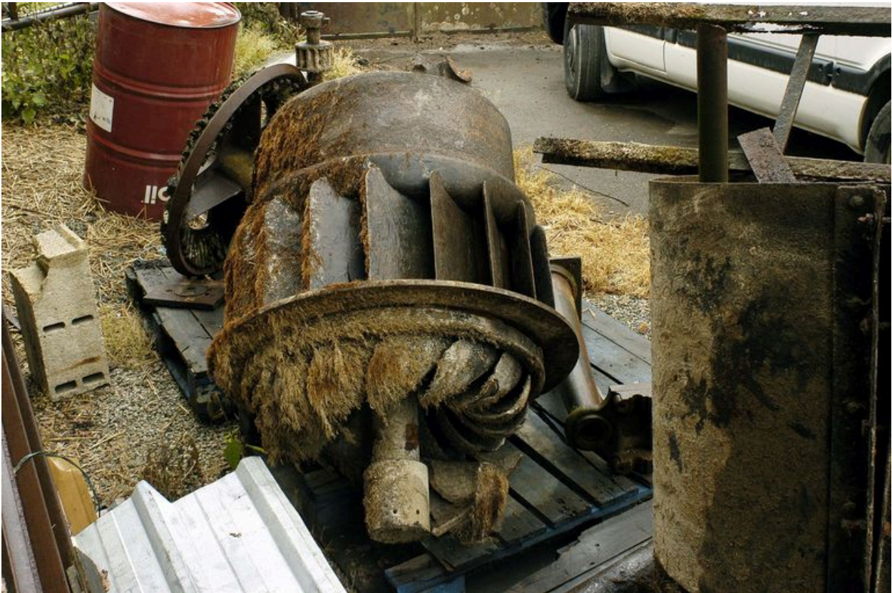
Vue d'ensemble de la turbine.
