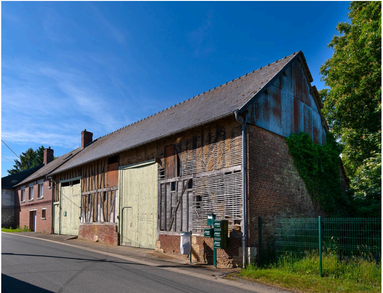
Ancienne grange sur rue, n°28 rue des Fresnes, vue depuis l'est.
