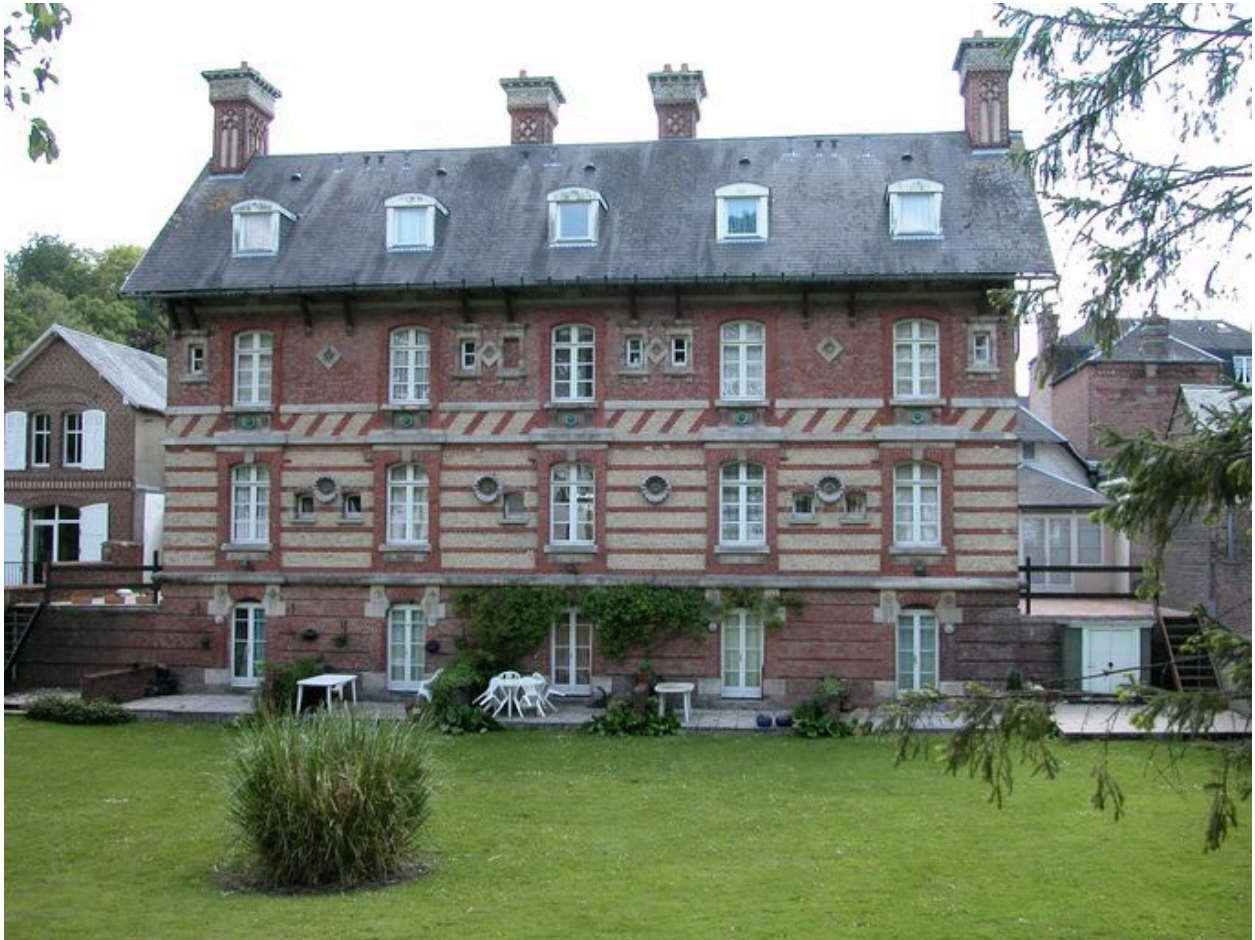
Elévation postérieure, côté digue.
