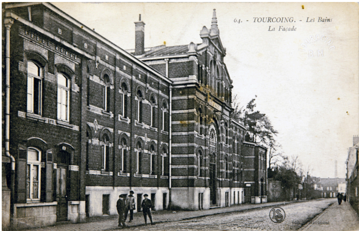
Vue générale de la façade sur rue depuis le sud, carte postale (Médiathèque municipale de Tourcoing).
