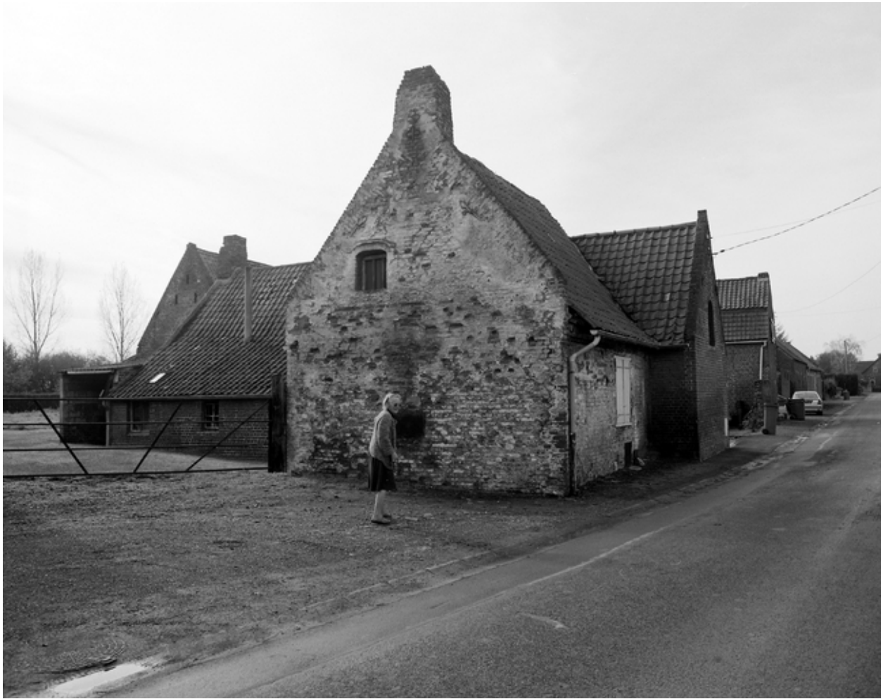
137, rue de la Caisse, pignon.
