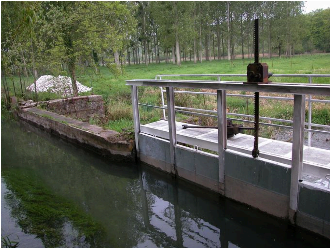
Le vannage de décharge et le déservoir du moulin.
