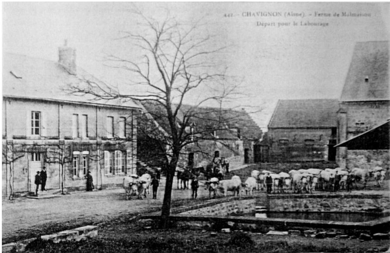
Vue ancienne des bâtiments agricoles (coll. part).
