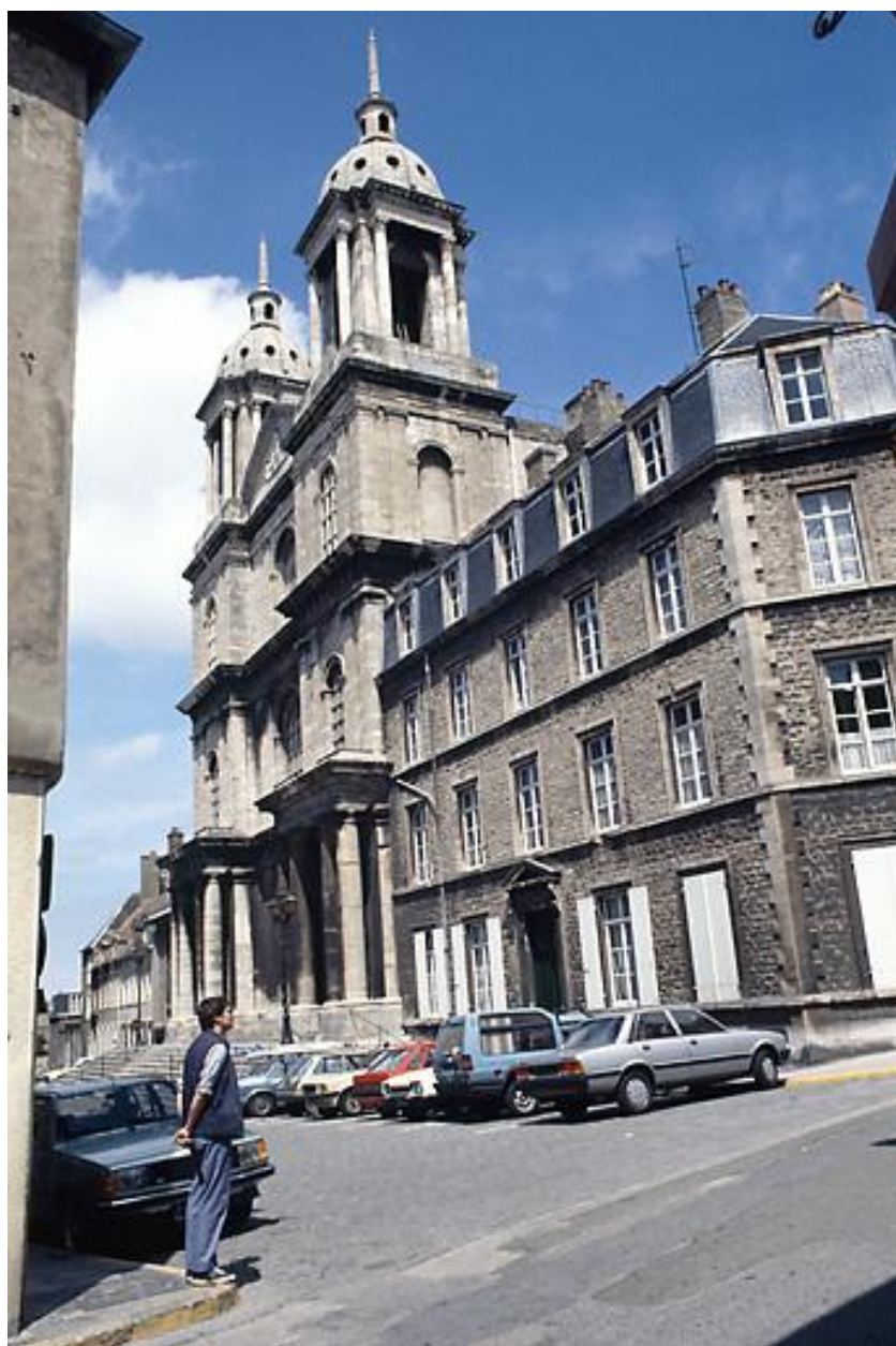
Presbytère, façade sur parvis.
