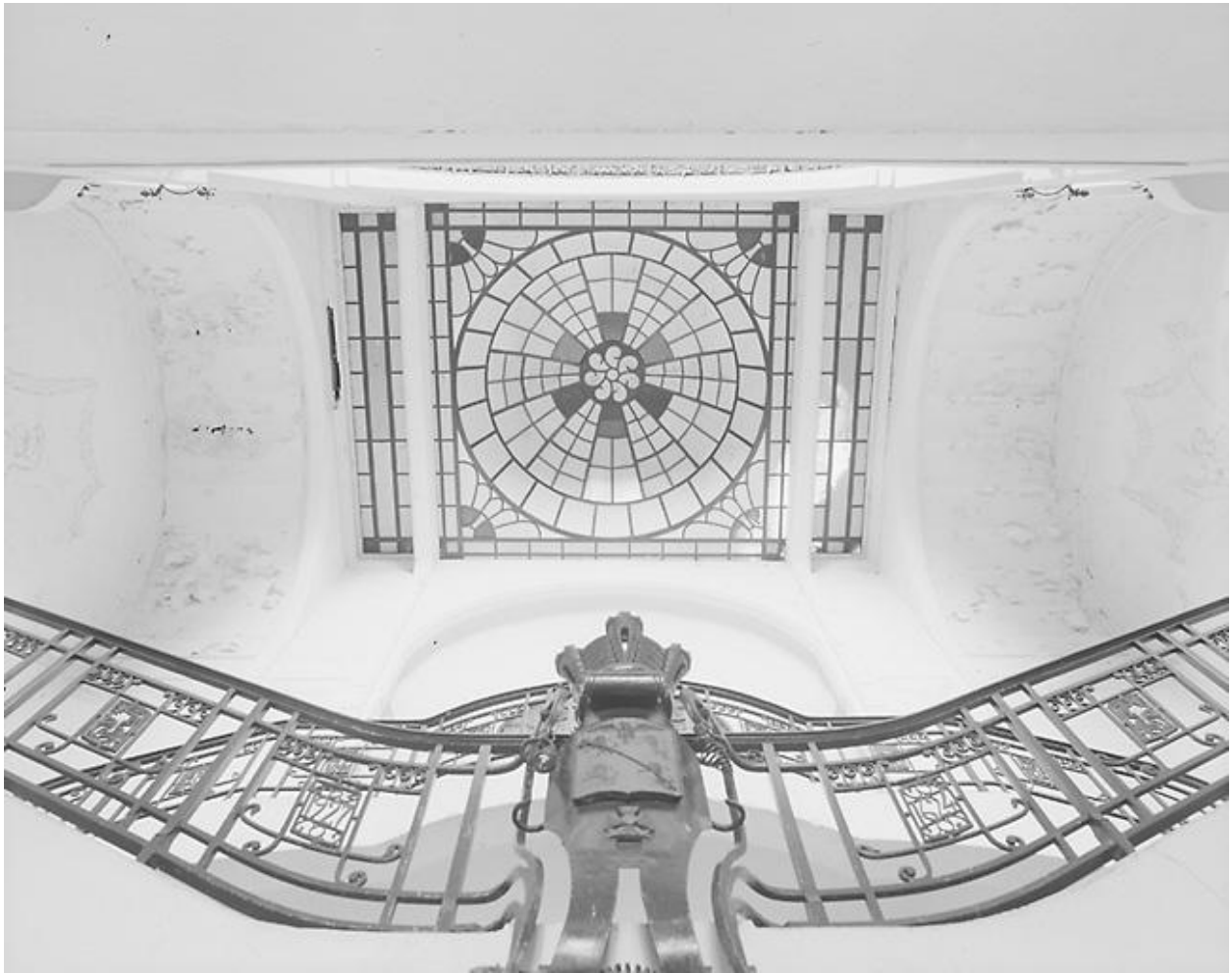
Rampe d'escalier et coupole vitrée (obturée en 2001).
