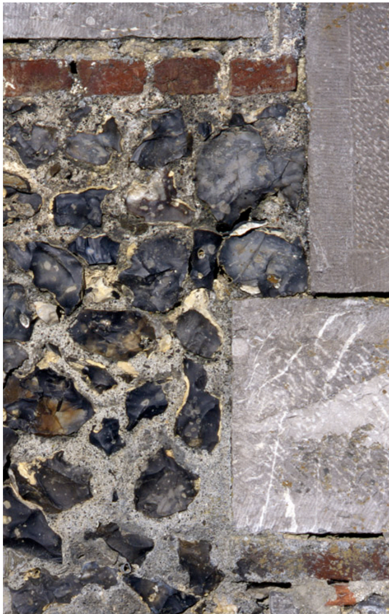
Dorengt, ferme (repérée), 14 ruelle Champagne : détail de la façade du logis montrant la mise en oeuvre des principaux matériaux.
