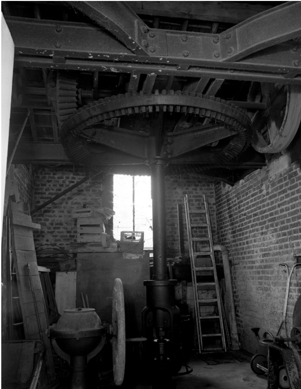
La turbine hydraulique installée en 1896.
