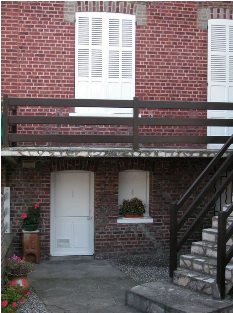
Détail du soubassement habitable.
