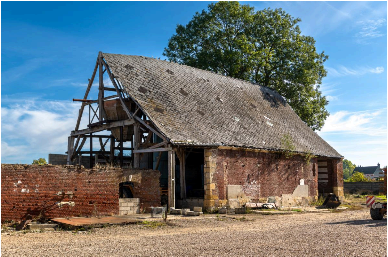
Ancienne grange, vue depuis l'ouest.
