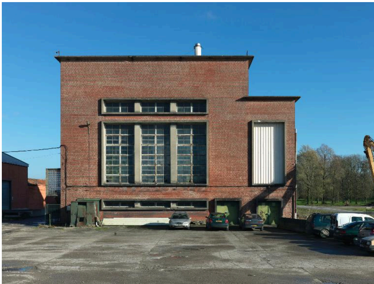
Façade ouest de la chaufferie à charbon, précédé de l'ancien parc à charbon.
