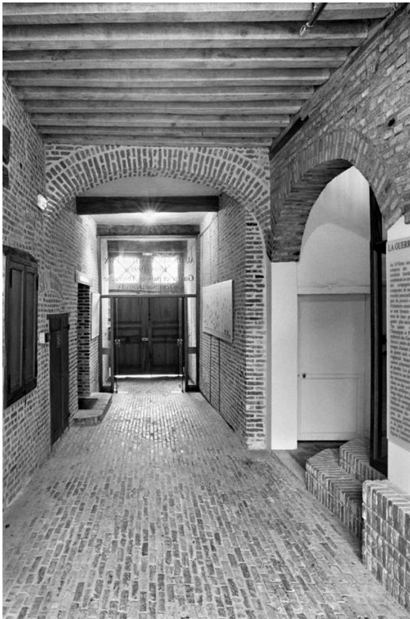
Vue du porche traversant, depuis la cour.
