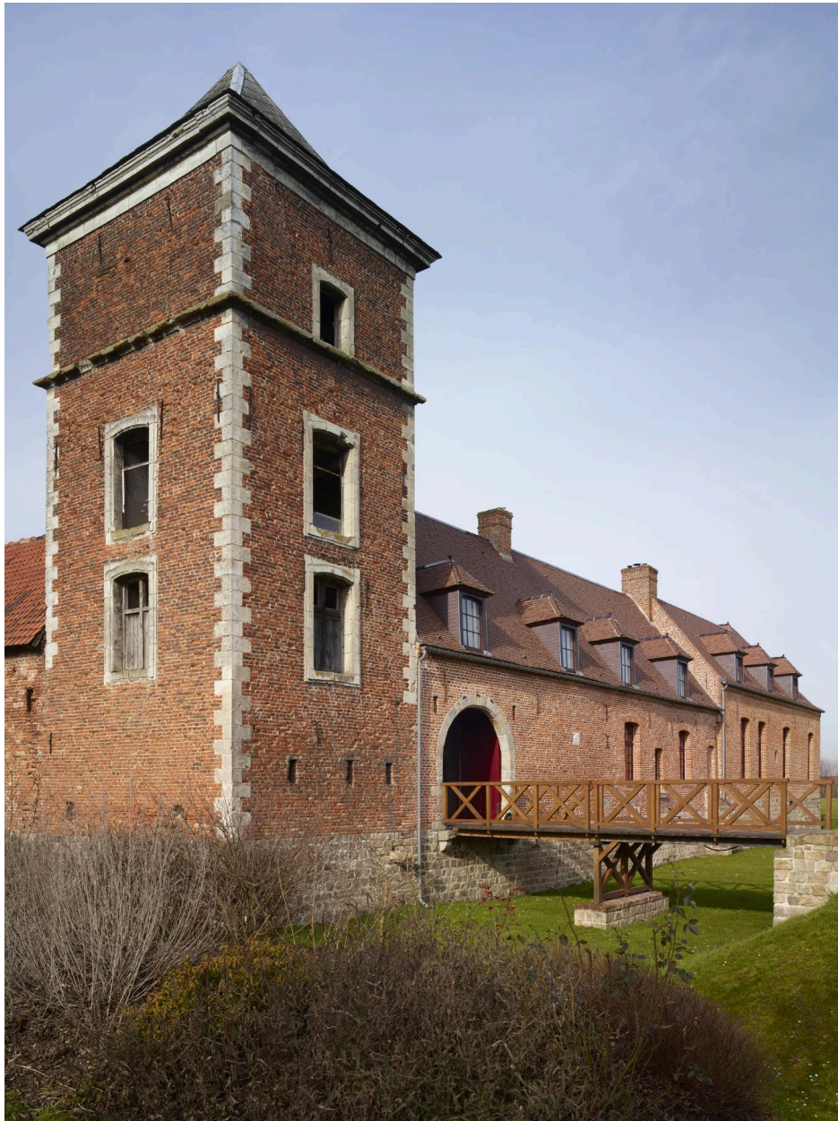
Ancienne ferme de Belleforière.
