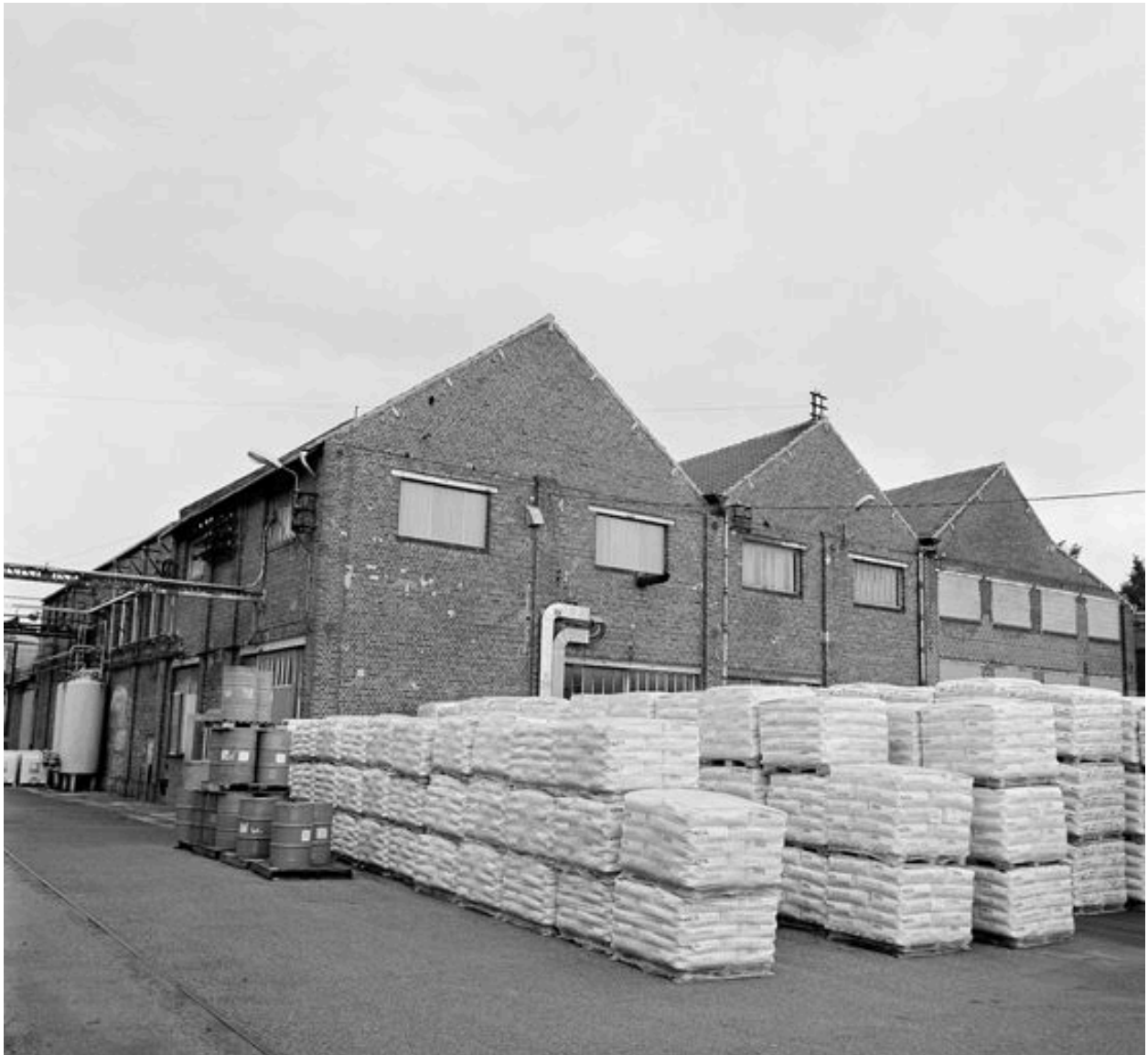
Atelier de fabrication et salle des machines.
