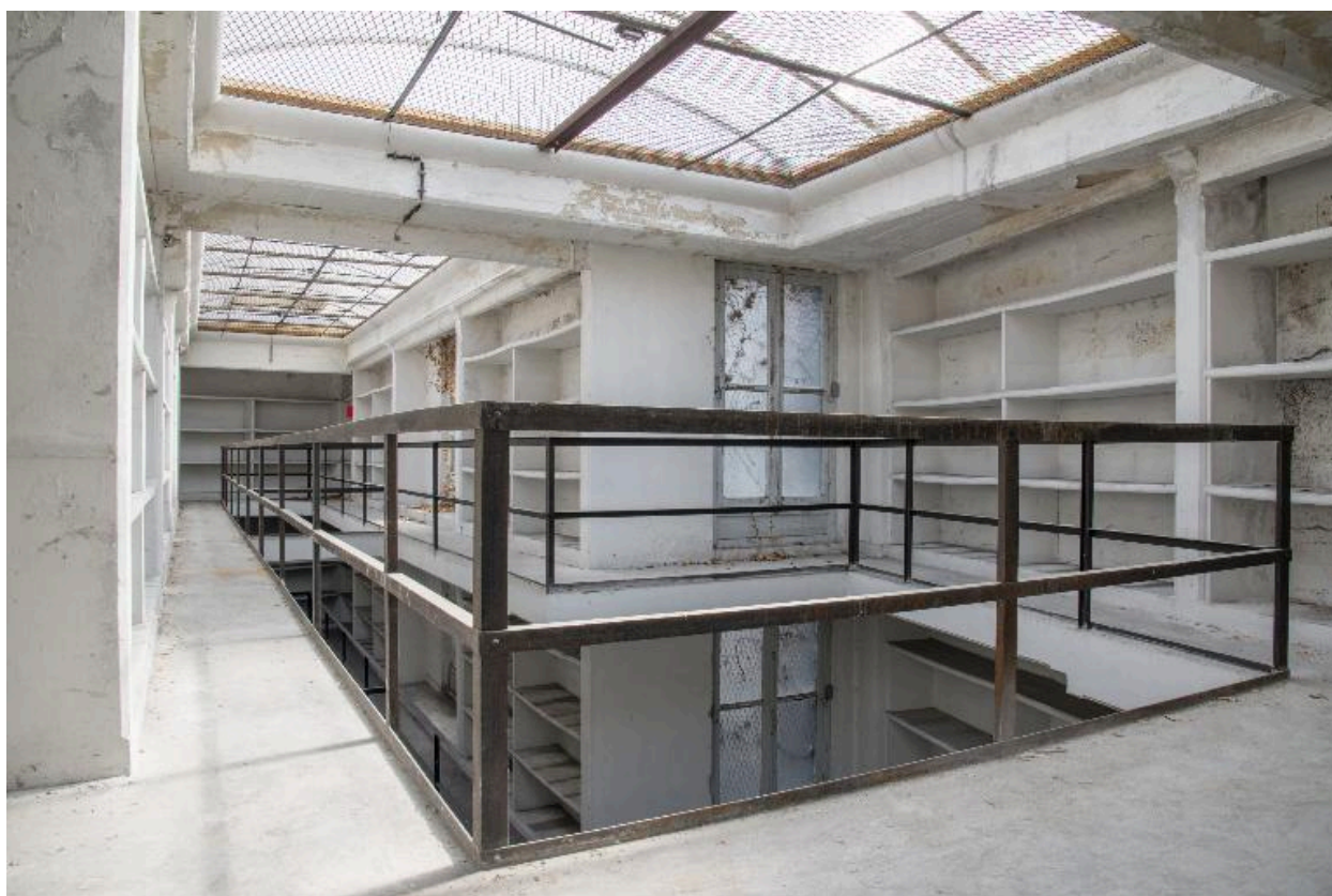
Bâtiment du dépôt, troisième étage : vue du vaisseau 4 vers l'est depuis le palier central.
