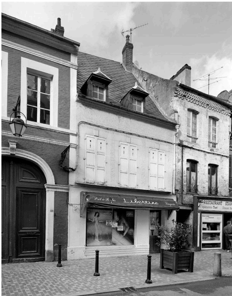
Vue de la façade de la maison située rue Camille-Desmoulins (N°141).
