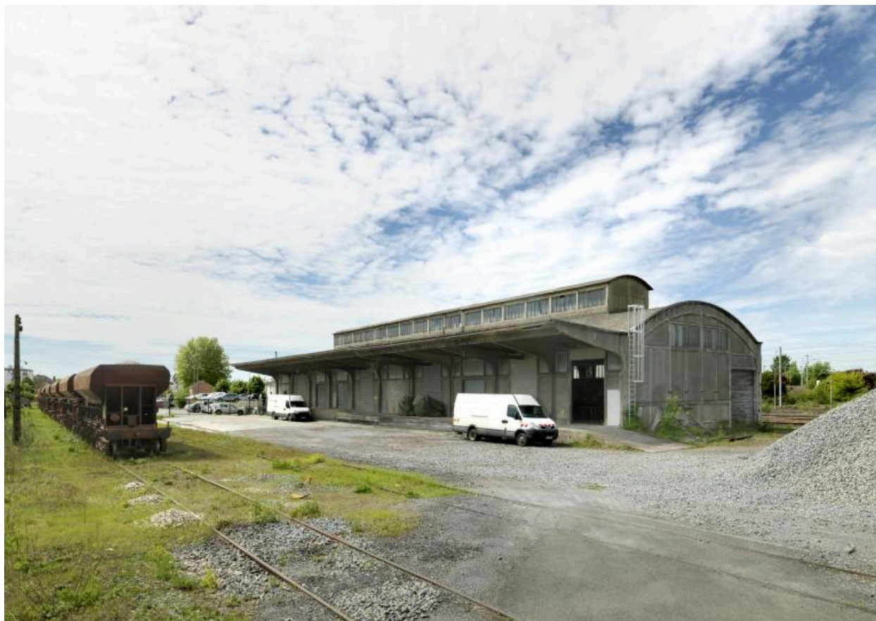
Halle de marchandises de type 2bis à 10 portes. Vue depuis le nord-est.
