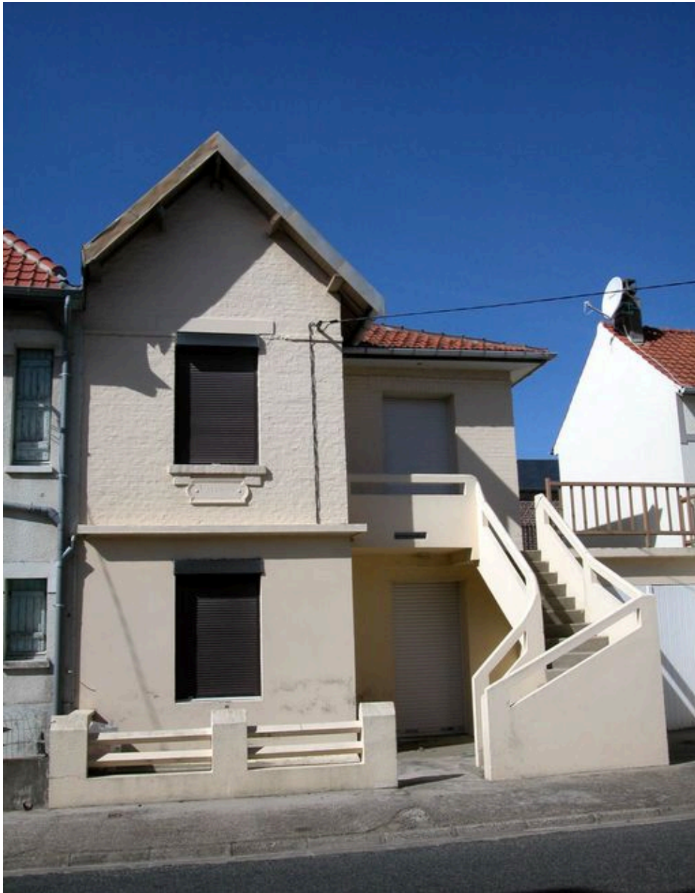
Le logis, élévation antérieure.
