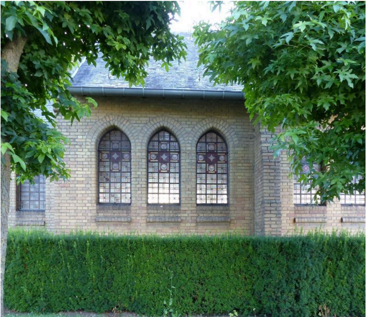
Vue d'un triplet de baies du mur ouest de la nef.
