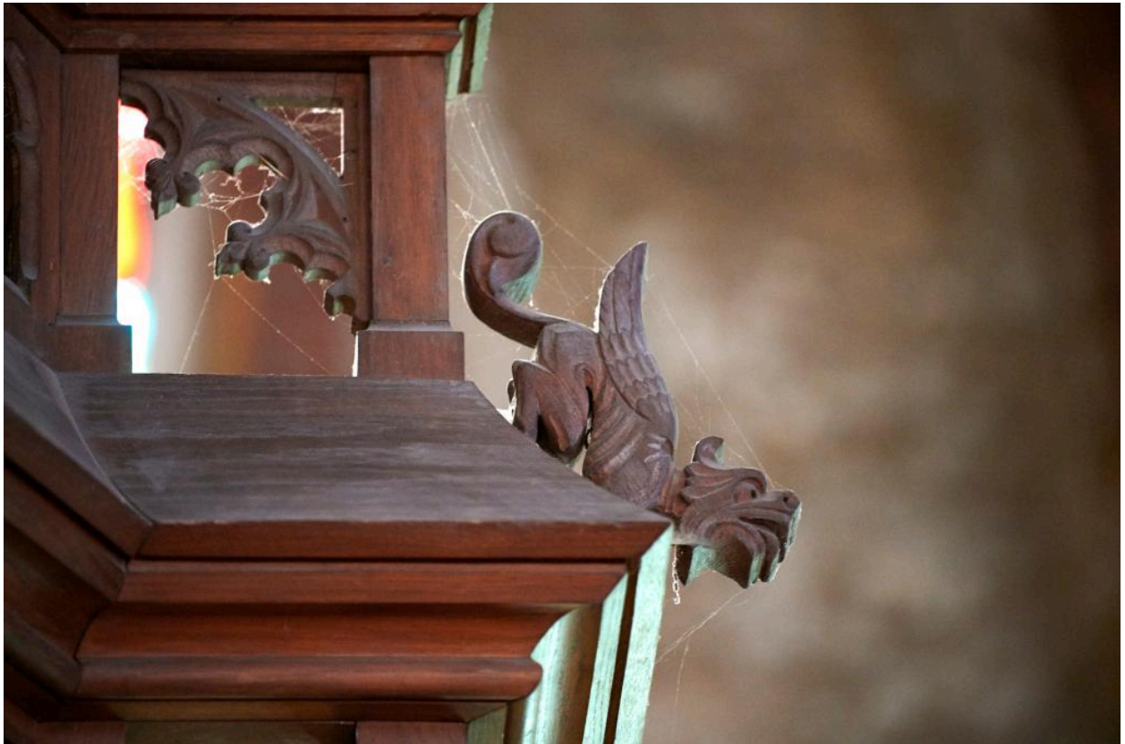
Détail du décor de la fausse toiture : chimère.
