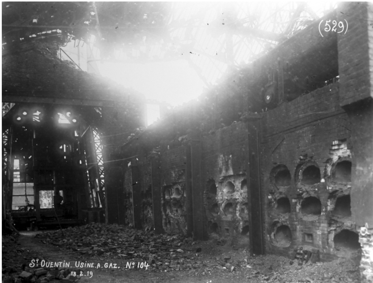
Vue intérieure du bâtiment des fours (ou cornues), en février 1919 (AD Aisne).
