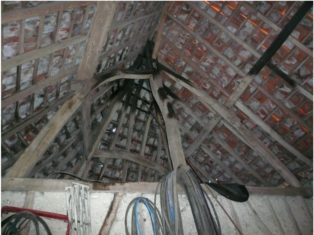
Vue d'une partie de la charpente de la grange.
