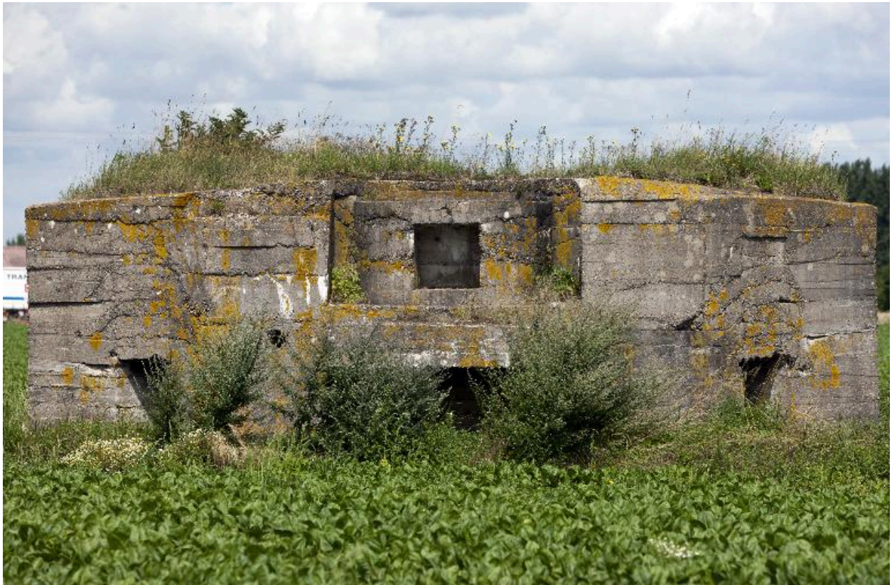
Vue antérieure, vers le nord-ouest.
