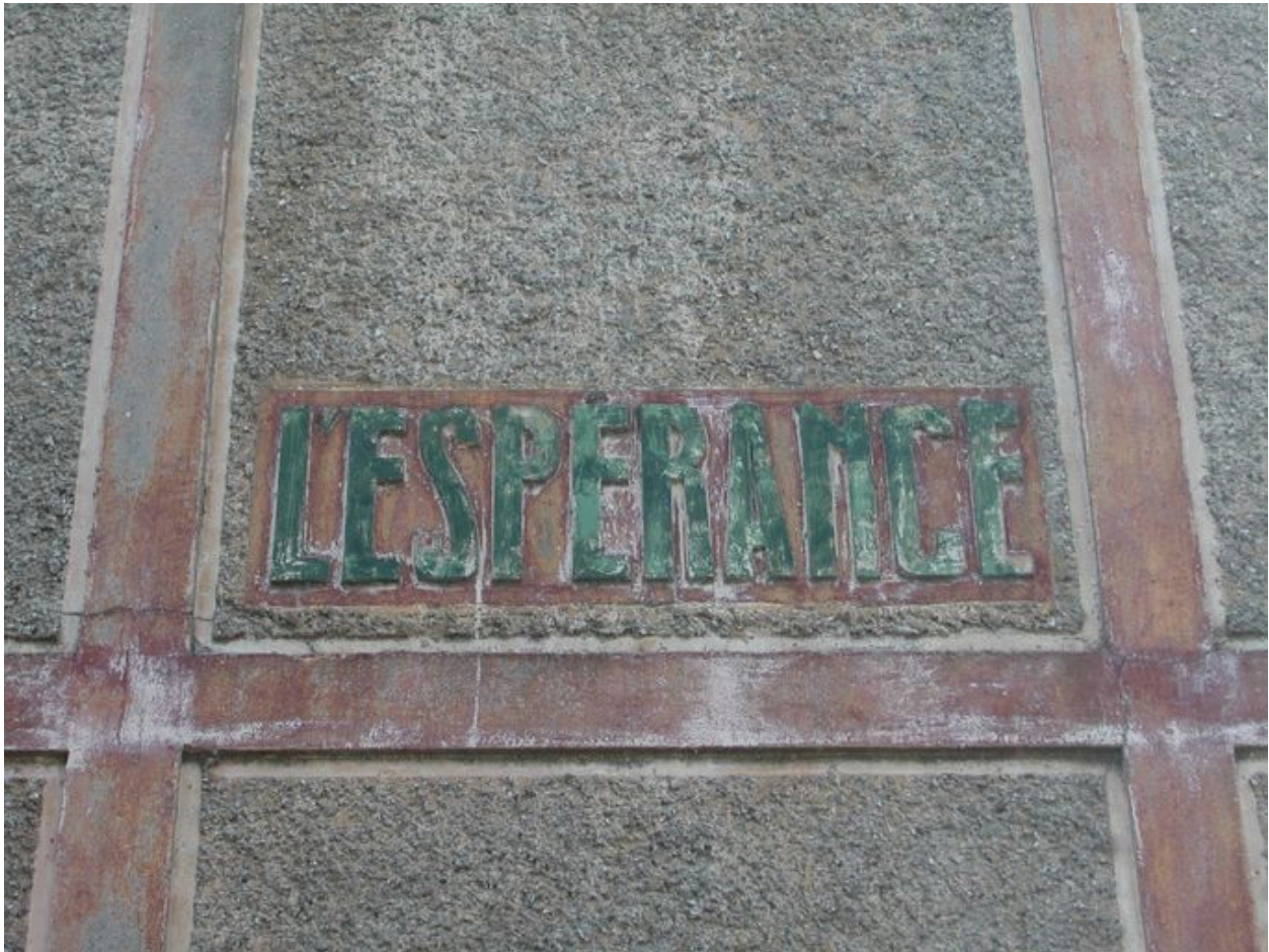
Détail de l'appellation portée sur la façade sur rue.
