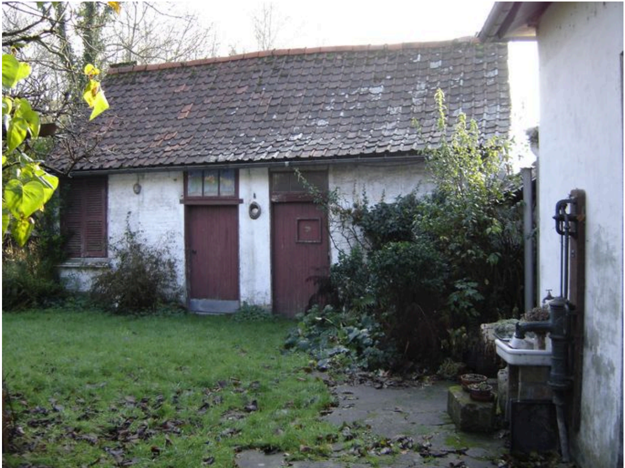
Vue des anciennes étables en fond de cour.
