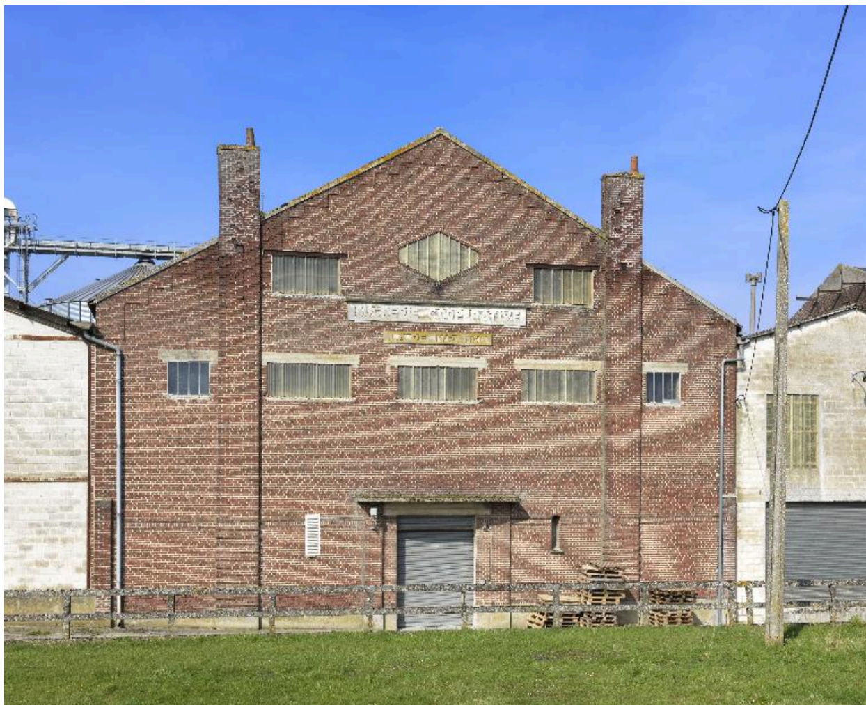
Pignon du bâtiment prolongeant l'atelier principal.
