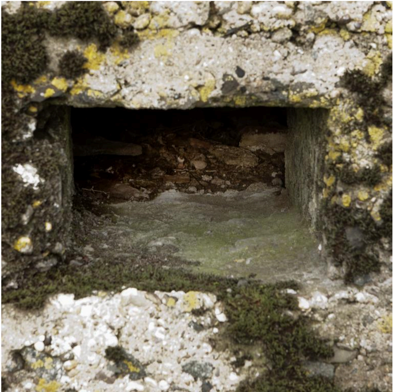
Détail de l'un des événements du dispositif de dispersion de l'onde de choc en cas d'impact d'un obus
