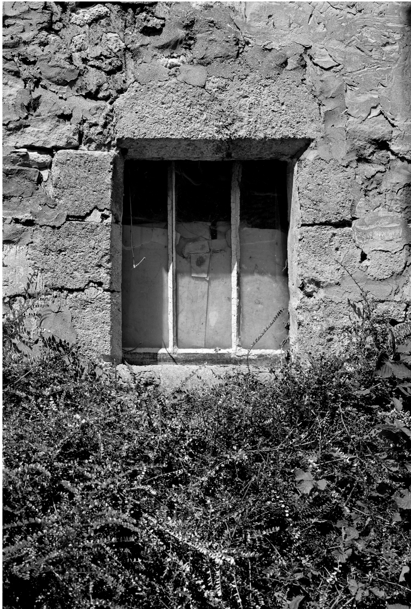
Fenêtre du rez-de-chaussée : vue de la cour intérieure.
