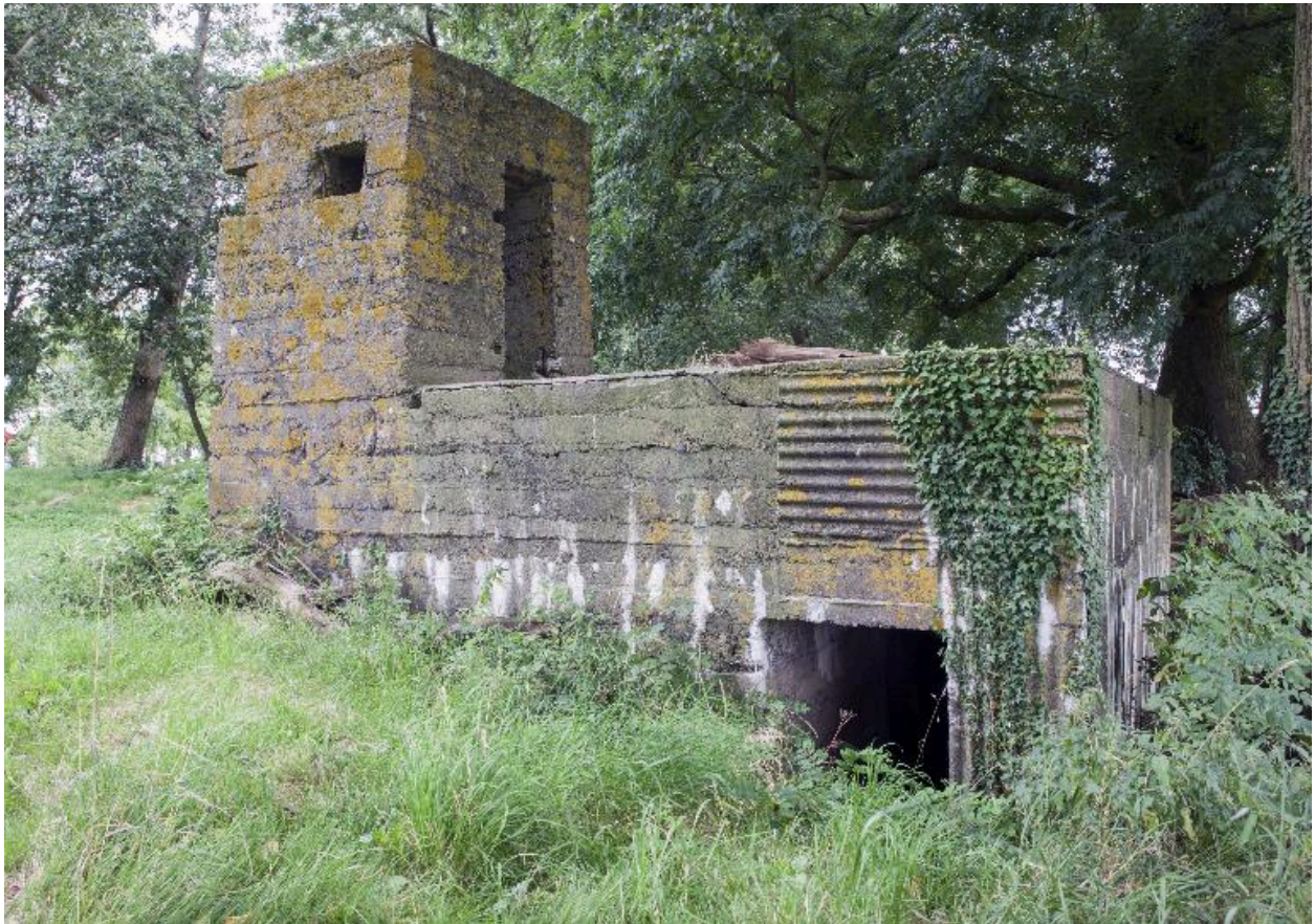
Vue latérale, vers le nord. Tourelle d'observation ou de communication optique et accès sud-ouest au couloir de distribution
