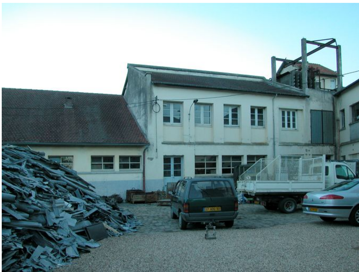
Façade est des bâtiments de la laiterie.
